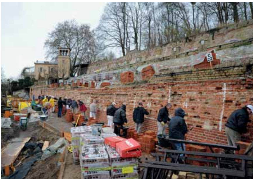
Im November 2009 halfen über 50 Maurer der Potsdamer Bauinnung. Foto: Roland Schulze
